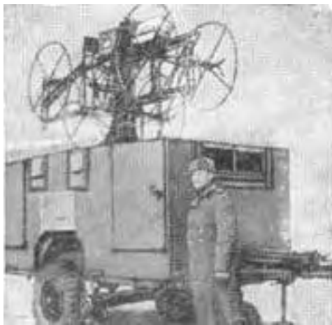
Станция орудийной наводки «Нептун»
