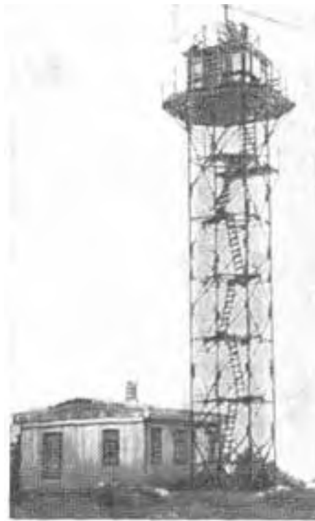
Экспериментальная станция дальнего обнаружения установленная в районе Токсово
