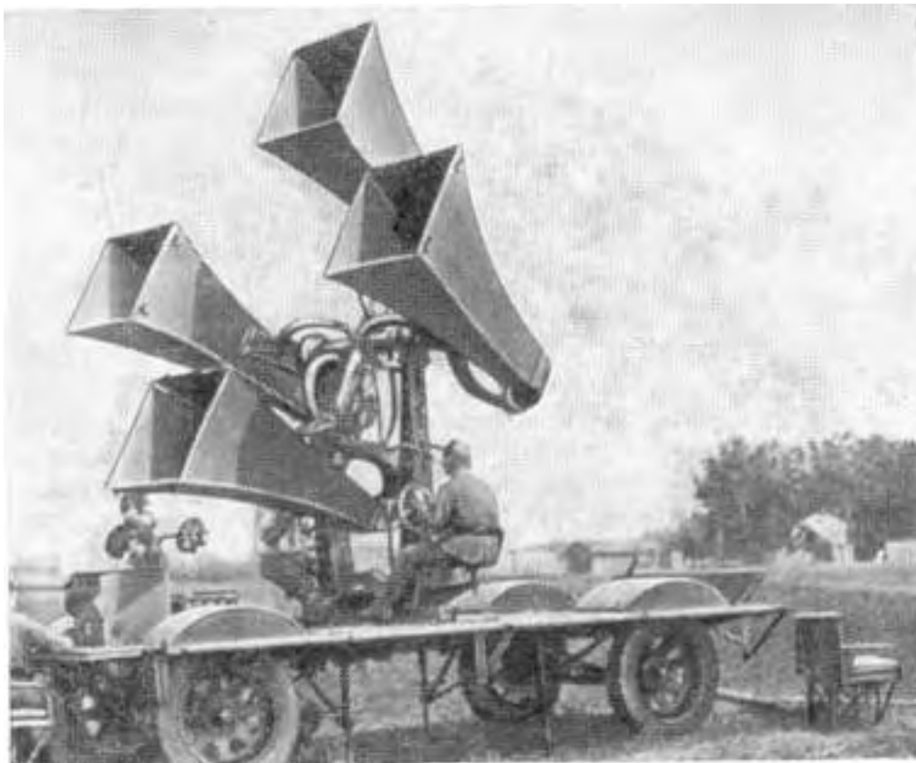
Звукоулавливатель ЗТ-2
