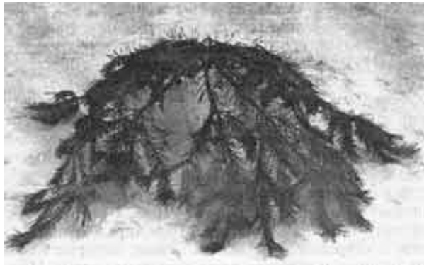
Фото 157. Каркас - перекрытие, изготовленное из фрагмента небольшой сосны
