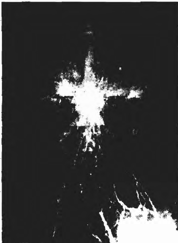
Рис. 10. Фотография эксперимента, иллюстрирующего действие электрического осциллятора, снабжающего энергией со скоростью семьдесят пять тысяч лошадиных сил. Разряд, создающий сильную тягу из-за нагрева воздуха, уносится вверх через открытую крышу здания. Самый большой размер по ширине примерно семьдесят футов. Напряжение — более двадцати миллионов вольт, а ток колеблется (меняется) сто тридцать тысяч раз в секунду.
