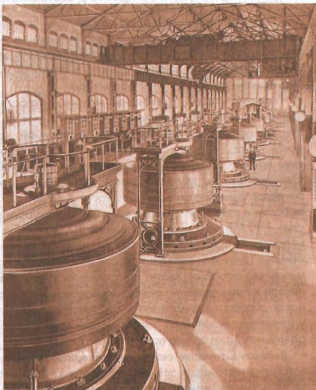
Зал динамо-машин мощностью в 5000 лошадиных сил на Ниагарской электростанции
