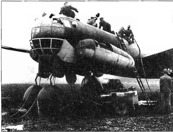
Юнкерс Ju 287 V1 во время подготовки к полету в Дессау. Шасси переставлено с трофеяного американского бомбардировщика «Либерейтор». Справа на снимке передвижная ремонтная мастерская, оборудованная электрогенератором для запуска турбореактивных двигателей.
