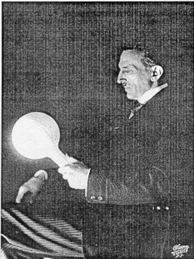
Тесла с газовой трубкой, чья внутренняя поверхность покрыта фосфором; трубка светится без прямого контакта с проводником. Тесла сделал это изобретение за полстолетия до начала употребления флуоресцентных ламп
